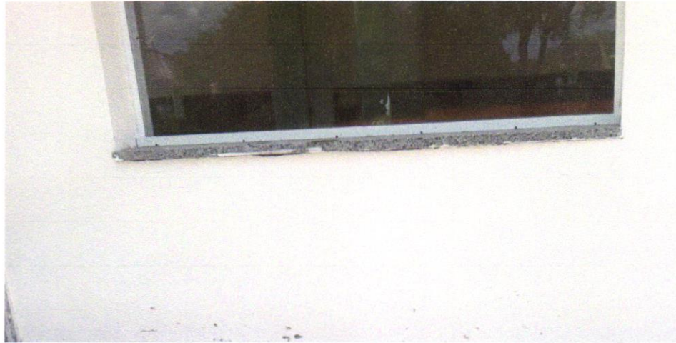
FOTO 17 – PEITORIL LINEAR EM GRANITO OU MÁRMORE, L = 15CM, COMPRIMENTO DE ATÉ 2M, ASSENTADO COM ARGAMASSA 1:6 COM ADITIVO. AF_11/2020
