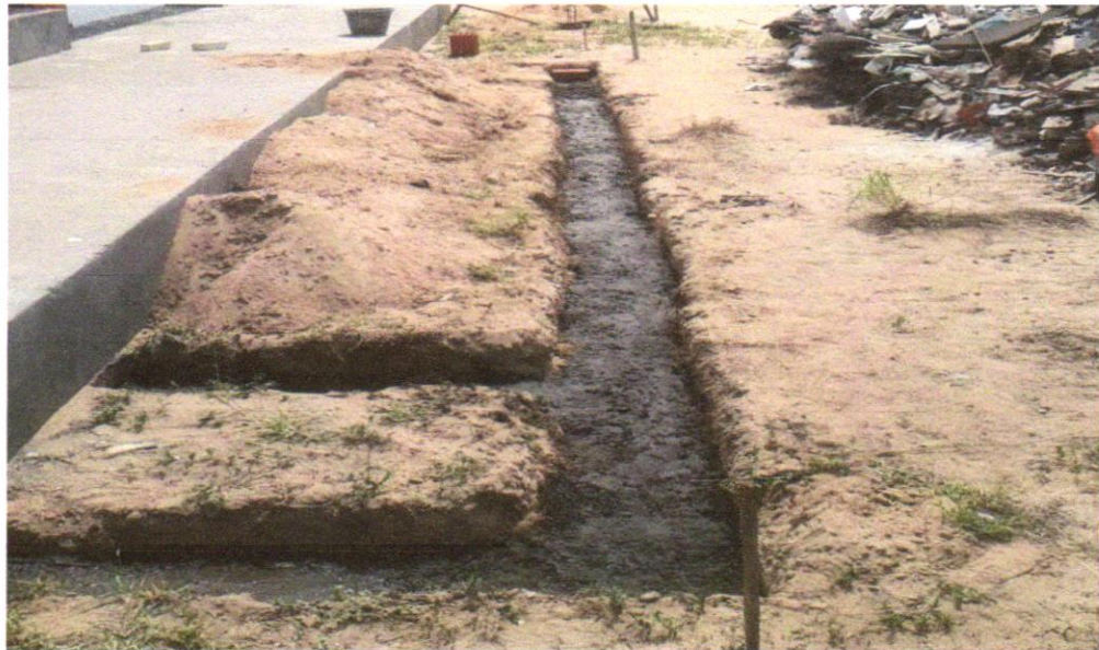
FOTO 01 – LASTRO DE CONCRETO MAGRO, APLICADO EM BLOCOS DE COROAMENTO OU SAPATAS, ESPESSURA DE 3 CM. AF_08/2017
