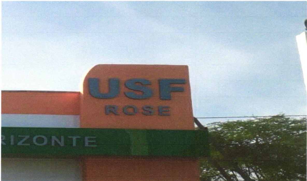
FOTO 05 – Letra em alumínio 45 x 45cm - instalado
