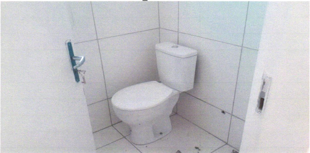
FOTO 26 – VASO SANITARIO SIFONADO CONVENCIONAL COM LOUÇA BRANCA - FORNECIMENTO E INSTALAÇÃO. AF_01/2020
