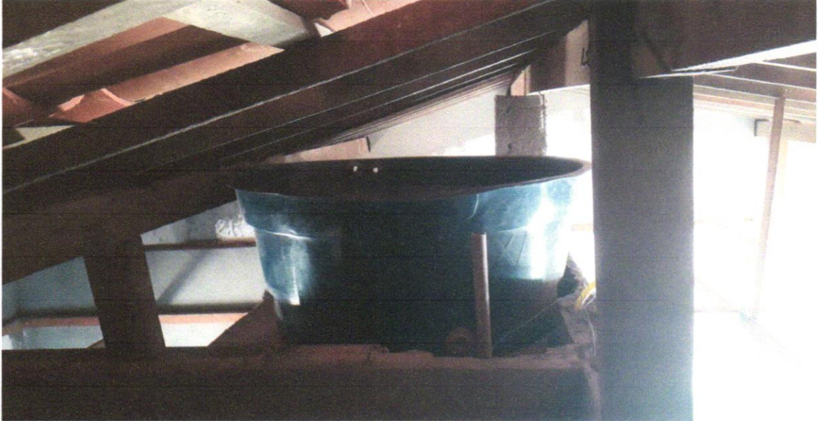
FOTO 25 –CAIXA D'ÁGUA EM POLIÉSTER REFORÇADO COM FIBRA DE VIDRO, 500 LITROS - FORNECIMENTO E INSTALAÇÃO. AF_06/2021
