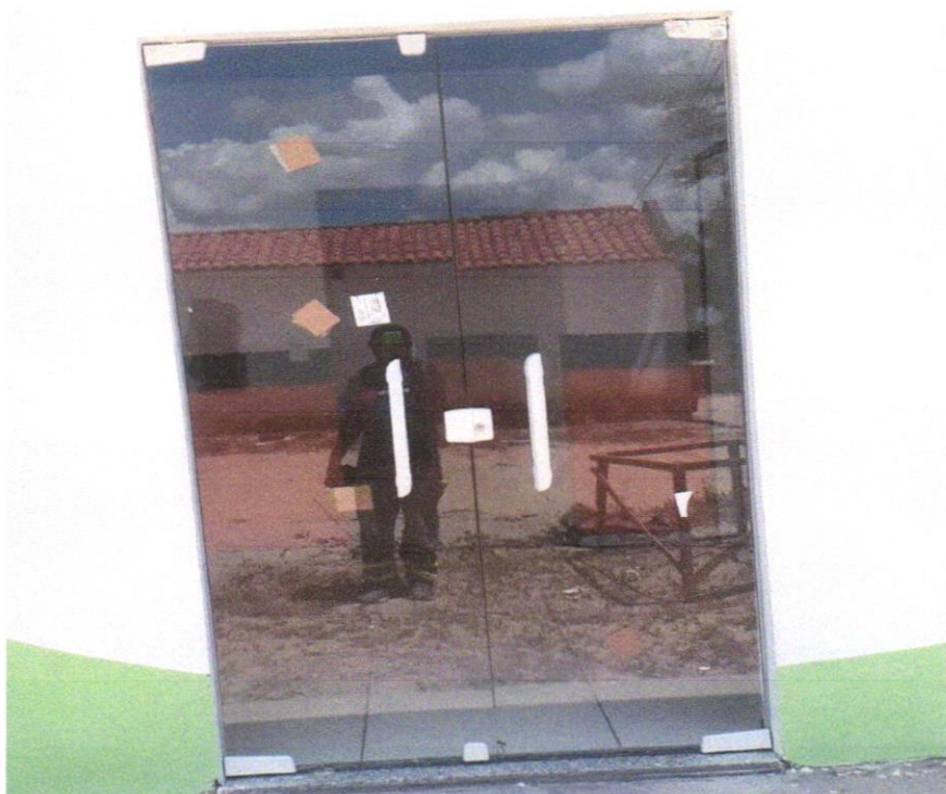
FOTO 13 – Porta em vidro temperado 10mm, incolor, inclusive ferragens de fixação e instalação, exclusive puxador - Rev 01_10/2021
