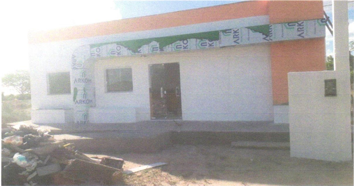
FOTO 03 -Revestimento metálico em alumínio composto (Alucobond), e=0,3mm, pintura Kaynar 500 composta por seis camadas, inclusive estrutura metálica auxiliar em perfil de viga "U" de 2" - fornecimento e montagem
