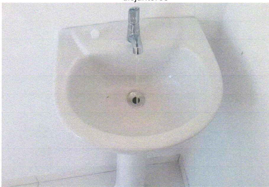
FOTO 24 – LAVATÓRIO LOUÇA BRANCA COM COLUNA, 45 X 55CM OU EQUIVALENTE, PADRÃO MÉDIO - FORNECIMENTO E INSTALAÇÃO. AF_01/2020
