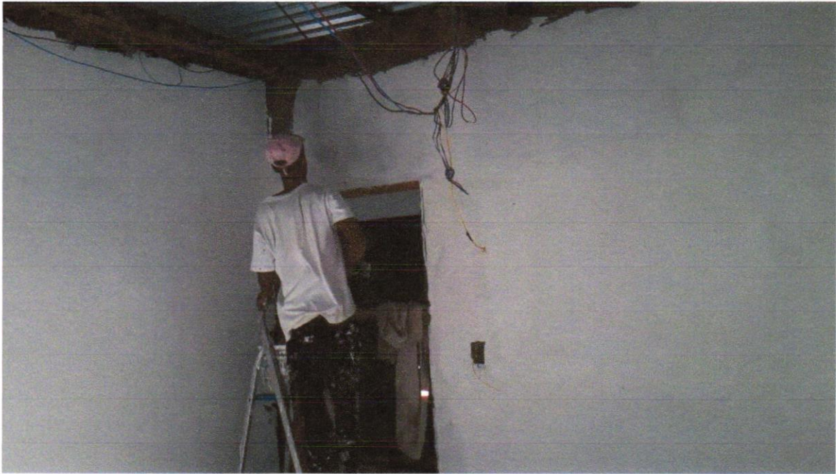
FOTO 11 – APLICAÇÃO E LIXAMENTO DE MASSA LÁTEX EM PAREDES, UMA DEMÃO. AF_06/2014
