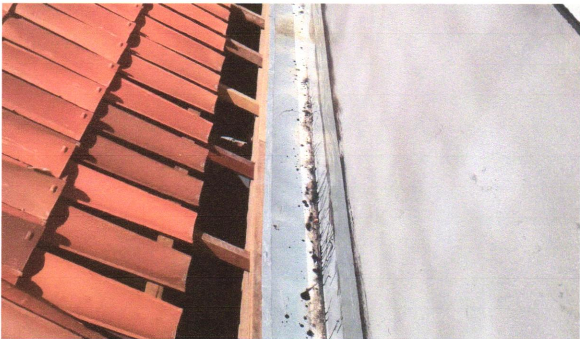
FOTO 20 – CALHA EM CHAPA DE AÇO GALVANIZADO NÚMERO 24, DESENVOLVIMENTO DE 33 CM, INCLUSO TRANSPORTE VERTICAL. AF_07/2019
