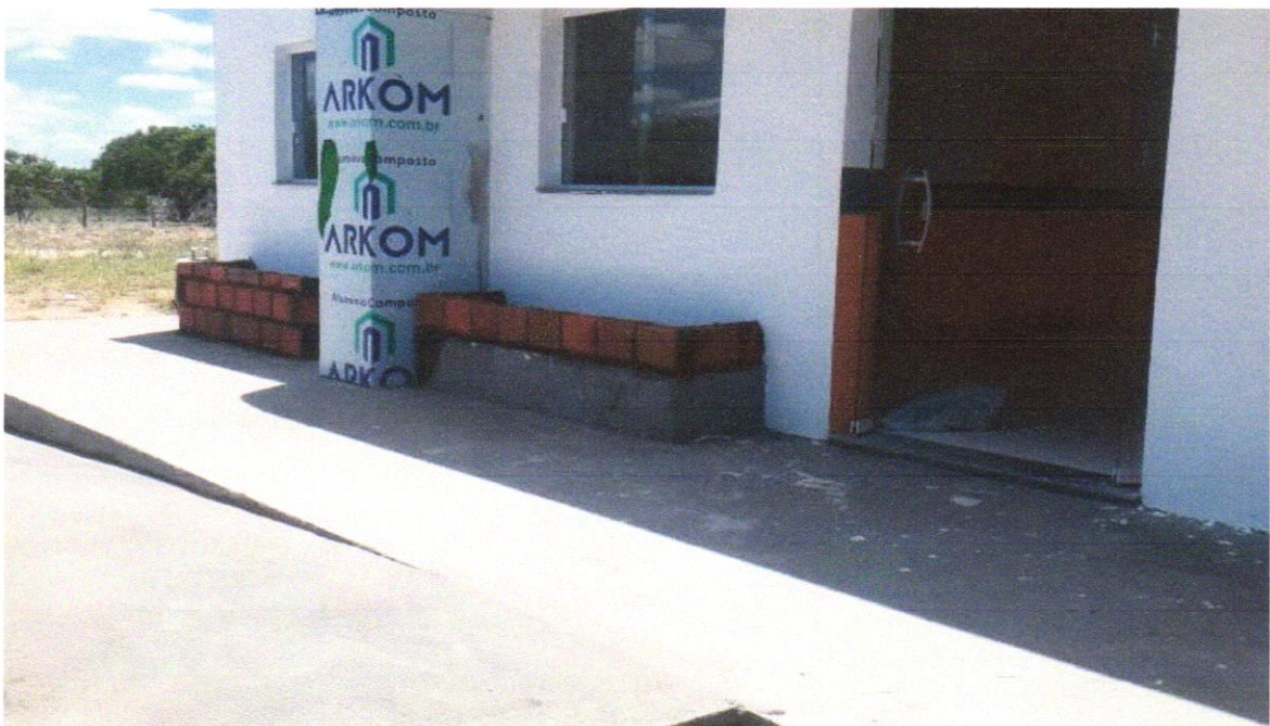
FOTO 08 – EXECUÇÃO DE PASSEIO (CALÇADA) OU PISO DE CONCRETO COM CONCRETO MOLDADO IN LOCO, USINADO,
