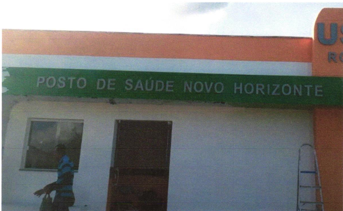
FOTO 04 - Letra em alumínio 20 x 20cm - instalado
