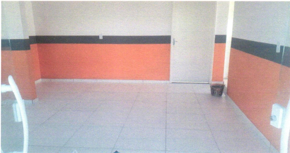
FOTO 12 – APLICAÇÃO MANUAL DE PINTURA COM TINTA LÁTEX ACRÍLICA EM PAREDES, DUAS DEMÃOS. AF_06/2014
