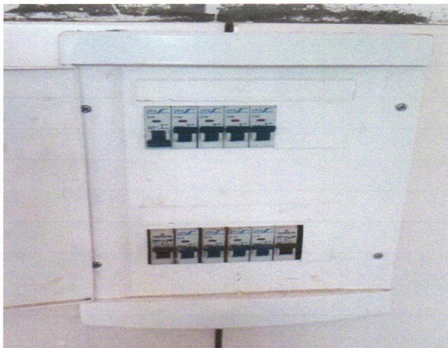
FOTO 23 – Quadro de distribuição de embutir, em resina termoplástica, para até 16 disjuntores, com barramento, padrão DIN, exclusive disjuntores
