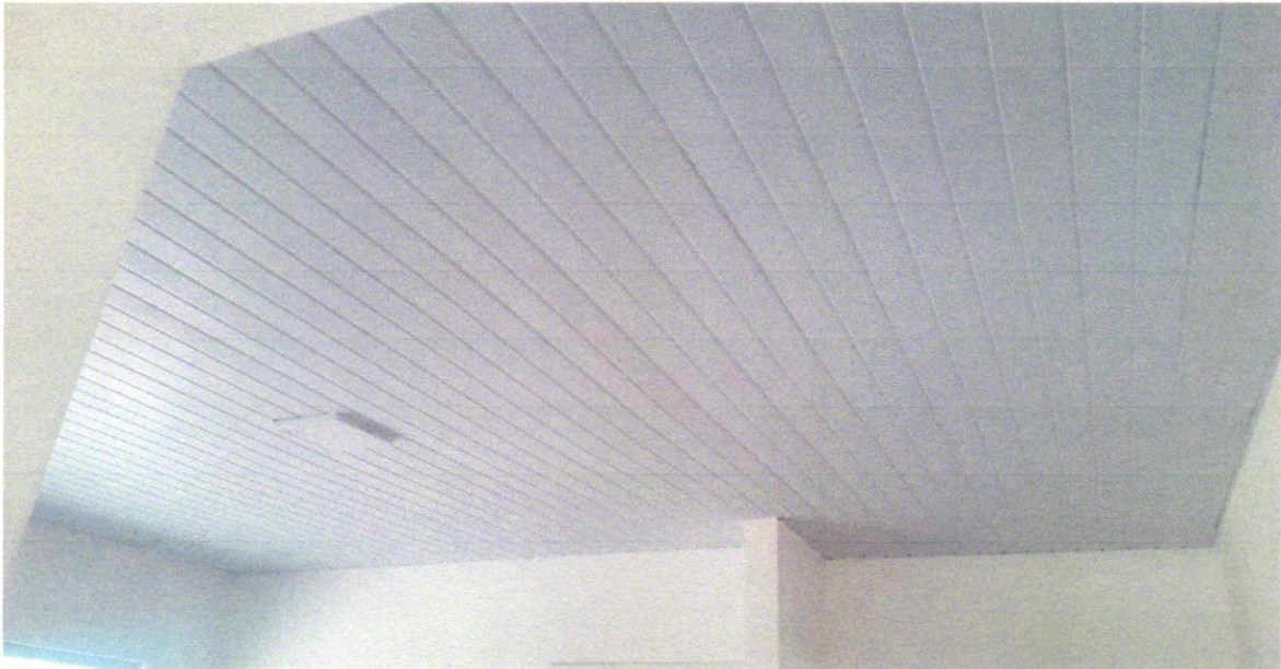
FOTO 19 – Forro de pvc, em réguas de 10 ou 20 cm, aplicado, inclusive estrutura para fixação (perfis em PVC) marca Araforros ou similar, instalado - Rev 06_10/2021
