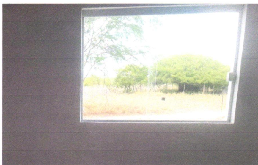
FOTO 14 – JANELA DE ALUMÍNIO DE CORRER COM 2 FOLHAS PARA VIDROS, COM VIDROS, BATENTE, ACABAMENTO COM ACETATO OU BRILHANTE E FERRAGENS. EXCLUSIVE ALIZAR E CONTRAMARCO. FORNECIMENTO E INSTALAÇÃO. AF_12/2019
